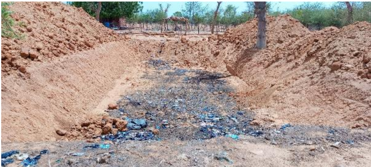
Photo 1: Tranchée de séchage à Kongoussi (ONG SI)
